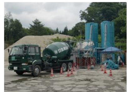
坑外プラント全景
