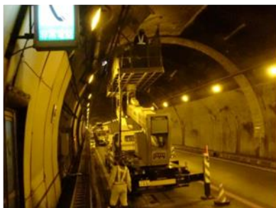
高所作業車（注入状況）
