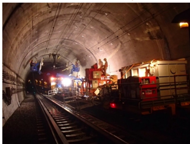
車上式プラント方式による施工状況
