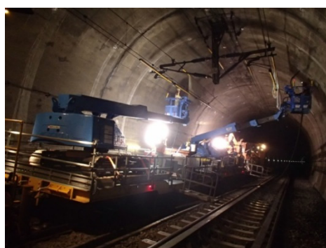
車上プラントによる施工状況
