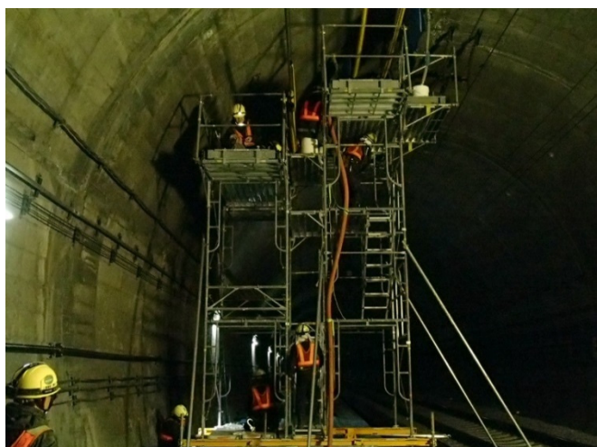
定置式プラント方式による施工状況
