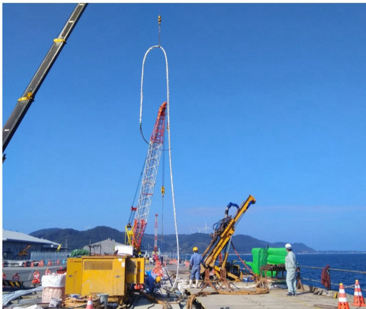
(上記写真：鋼線建込み状況)
