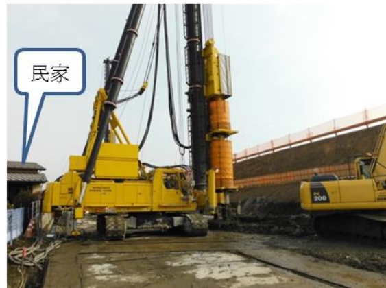
民家付近の施工状況
