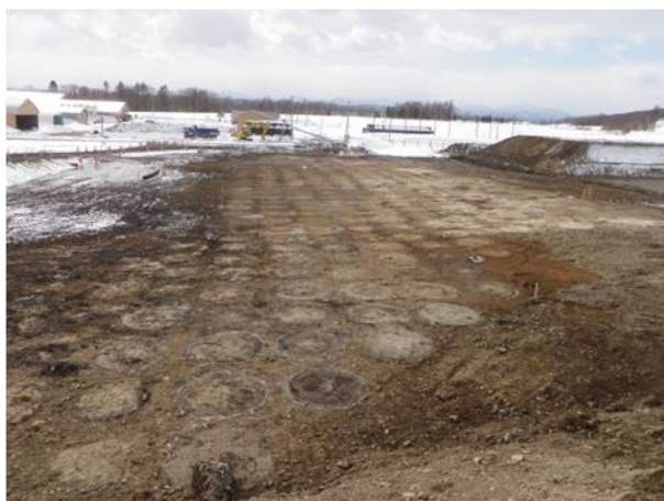
改良体出来形
