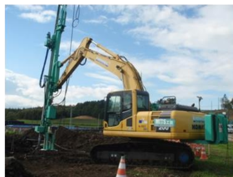
MITS工法施工機
