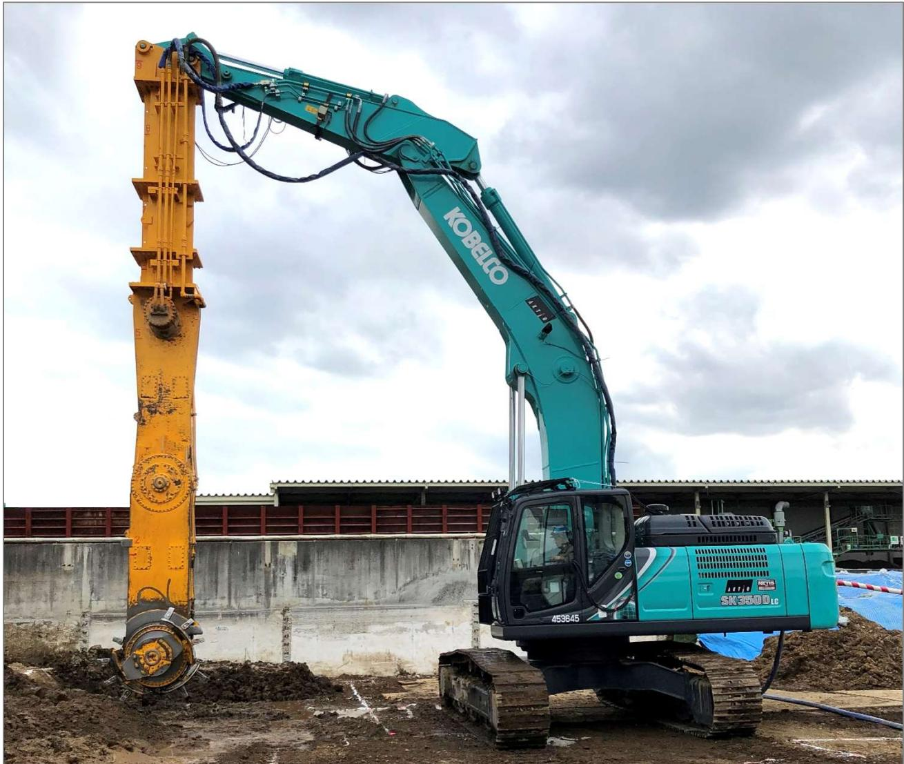
新設プラント建設工事のうち、 $\phi 13.0\text{m} \times 2$ 基と $\phi 15.6\text{m}$ の円形槽基礎下とポンプ置場基礎下の部分改良に、中層混合処理工法のW I L L工法が採用されました。
