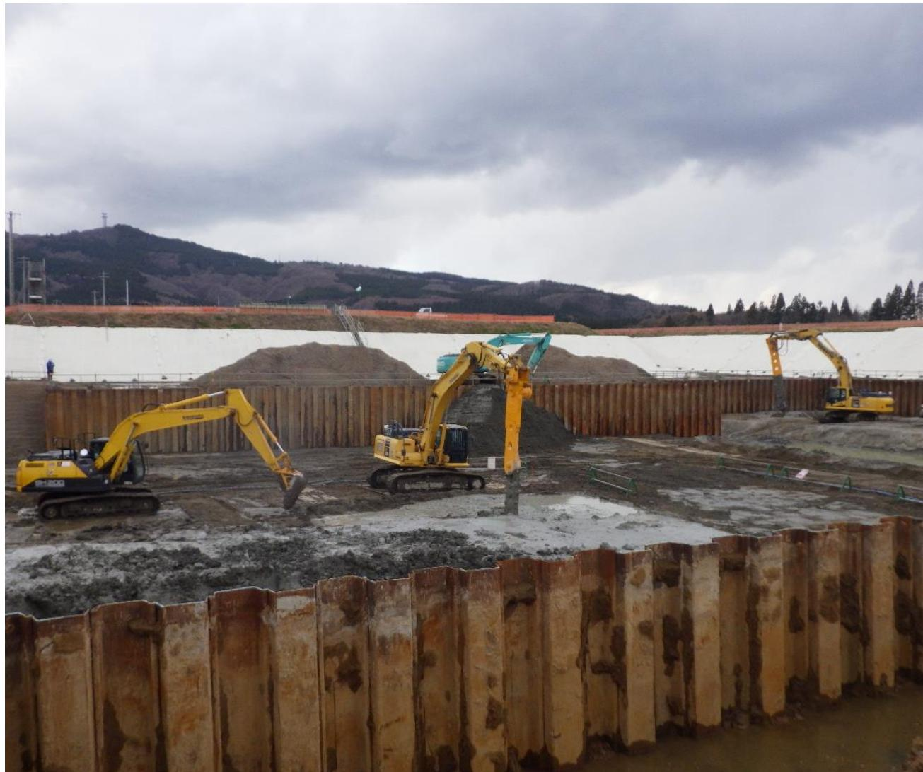
樋門・樋管基礎の支持力増強および沈下抑制を目的として、中層混合処理工法であるWILL-i工法が採用されました。
