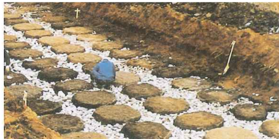
DJM改良柱体頭部 (φ1m) (杭状施工) DJM columns'head in shallow excavation
