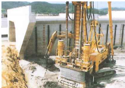
橋台背面基礎の補強 (DJM2070)
