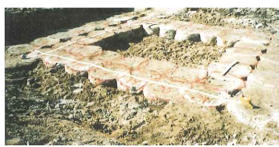
DJM改良柱体頭部 (φ1m) (接円〜ラップ施工) DJM columns' head in shallow excavation
