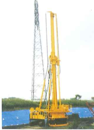
高圧線下施工 (DJM2070H)
